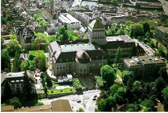
Kollegienhaus mit Blick auf die Stadt
